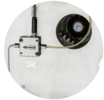
Schmierstellensensor zur Überwachung der Großradschmierung
